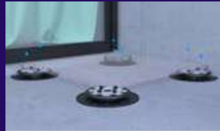
2° Eliminación de separadores en borde y esquina
