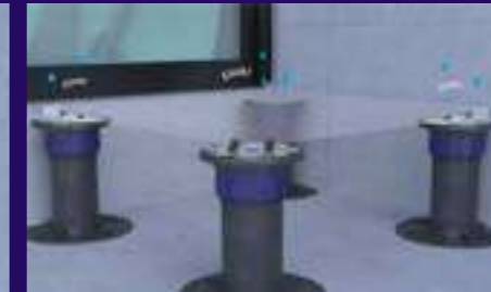
2° Eliminación de separadores en borde y esquina
