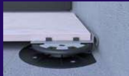
5° Creación junta de contorno
