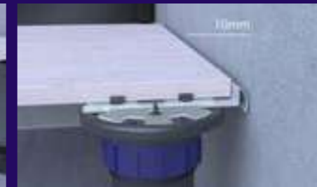
5° Creación junta de contorno
