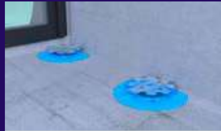
1° Corte de bases en borde y esquina
