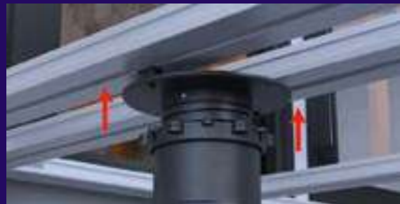
3º Colocación de plots
