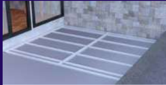
1º Montaje sub-estructura
