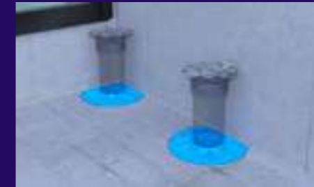
1° Corte de bases en borde y esquina
