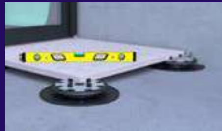
4° Nivelado de baldosa
