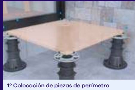
1º Colocación de piezas de perímetro
