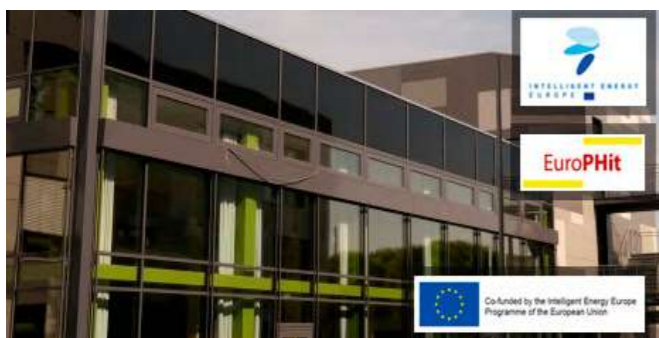
EUROPHIT (Mejora del rendimiento energético de la renovación e integración paso a paso de las energías renovables): Programa: CIP. Energía inteligente Europa. Web: http://europhit.eu/
