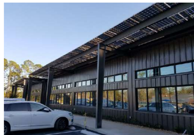
Cliente: Computech City Arquitecto: Process Arquitectura
